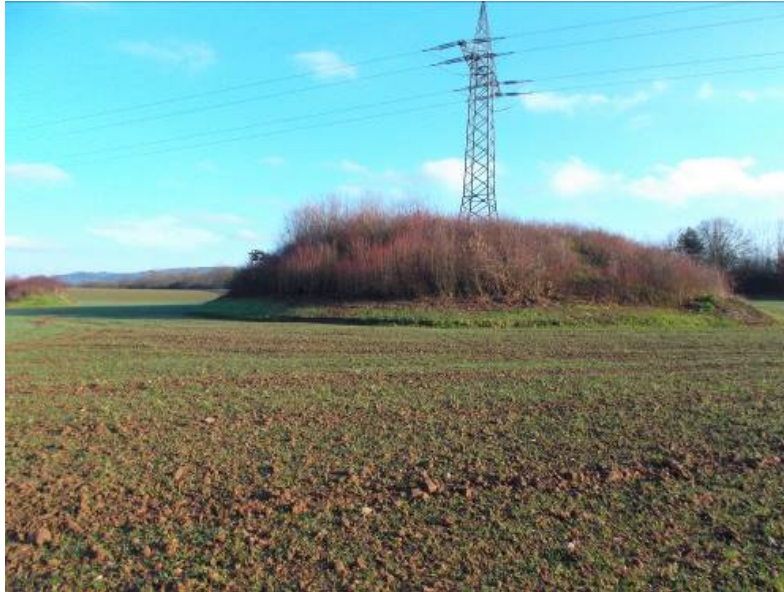
Foto Nr. 1: Acker, im Hintergrund Mastfundamente und Autobahnböschung.
