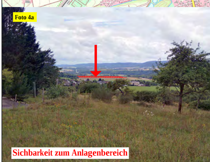
Sichtbarkeit zum Anlagenbereich
