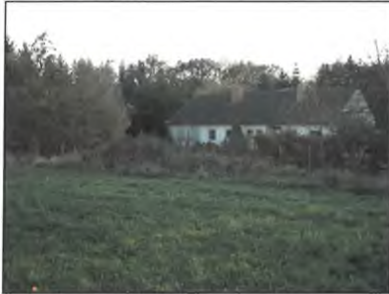
Foto 11: Ansicht ehem. Lehrerwohnhaus von Nordosten (KBH Architektur, Okt. 2013)
