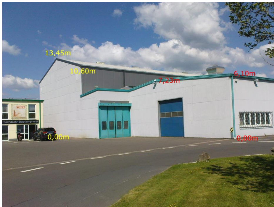
Abb.: Ansicht gegenüberliegende Halle (GE-Gebiet Laufeld II)
